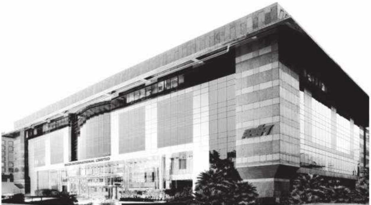
साकेत, नई दिल्ली स्थित इरकॉन का कॉर्पोरेट कार्यालय भवन
