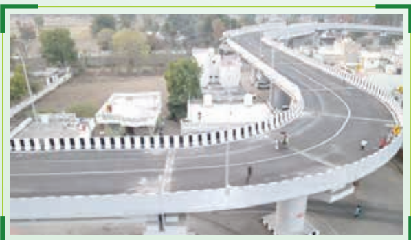
ROB in lieu of LC 28, ROB Gujarat Project
