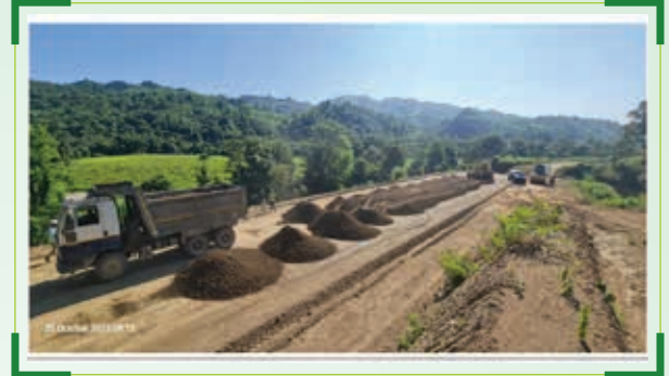
GSB Top Layer Laying @KM 3+400, Myanmar
