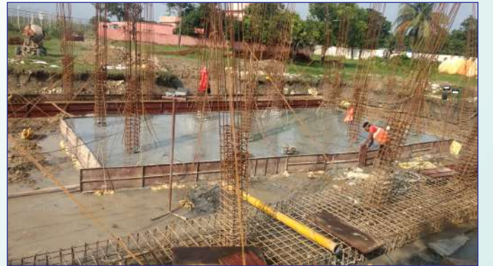
निर्माण स्थल, एलपीएआई परियोजना-जोगबनी, बिहार
