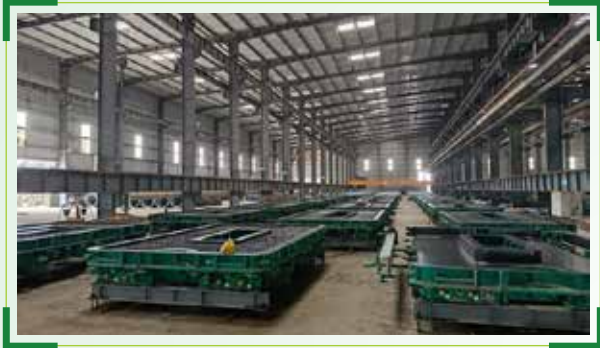
किम में ट्रैक स्लैब निर्माण कारखाना (टीएसएमएफ)
