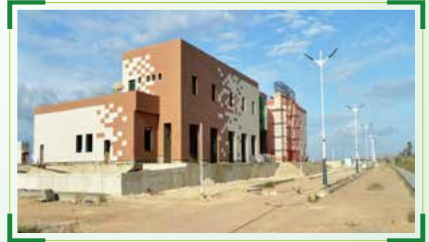
रेलिजेन रेलवे स्टेशन, अल्जीरिया
