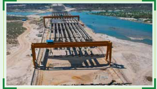
हरिद्वार बाईपास परियोजना के प्रमुख पुल पर गर्डर लॉन्चिंग और उप संरचना का कार्य प्रगति पर
