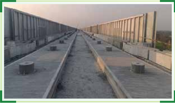
237 किमी, MAHSR T-2 पर वायाडक्ट पर आरसी ट्रैक बेड का कार्य
